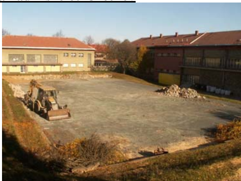
zahájení prací - říjen 2008
