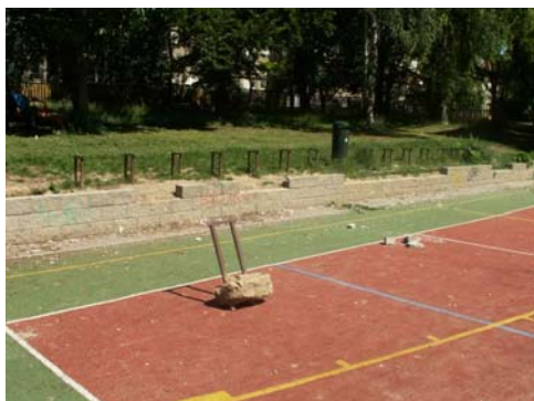
zničené hřiště za bývalou zvláštní školou
